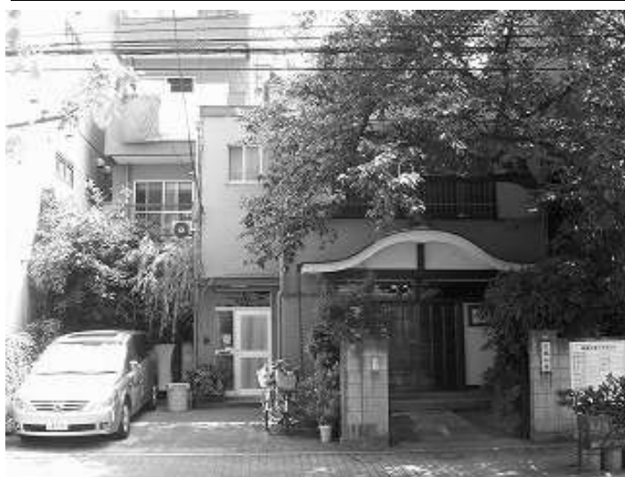
→ 工事前の本明寺です 正面から撮影
