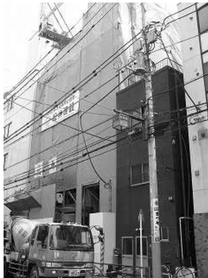
五階立上がり 型枠・配筋 (七月十八日)
