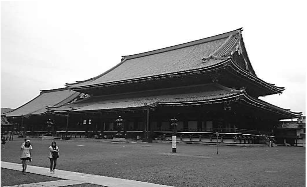
真宗本廟（京都・東本願寺）両堂等御修復完了 （2016年6月22日撮影）
